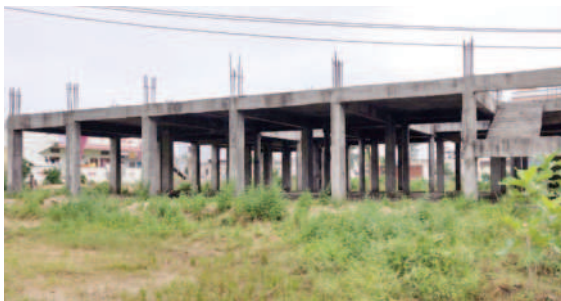
అసంపూర్తిగా కార్యాలయం నిర్మాణం పనులు
